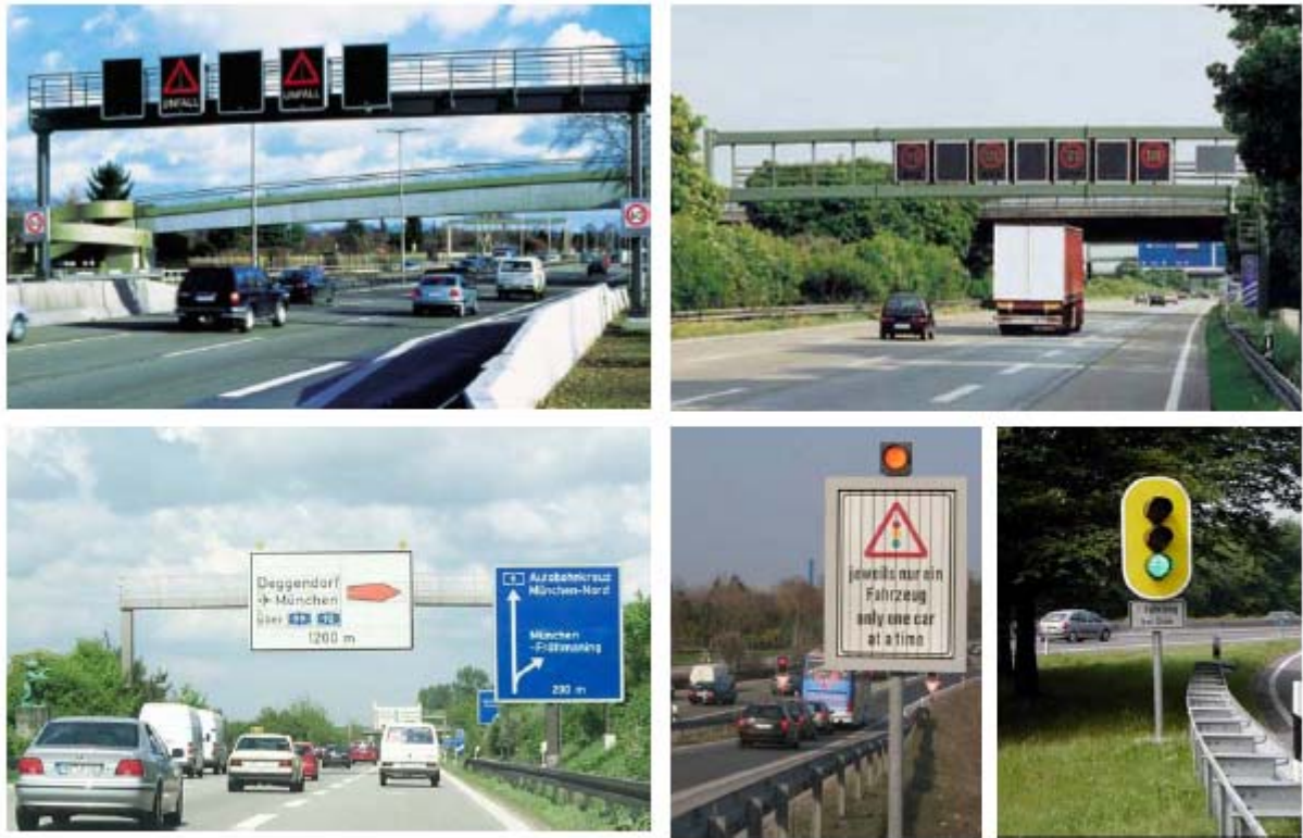
Abbildung 2: Kollektive Verkehrsinformations- und -leitsysteme in Deutschland Streckenbeeinflussungsanlagen (oben), Netzbeeinflussungsanlage (unten links); Zuflussregelung in München (unten Mitte) und Bochum (unten rechts).
