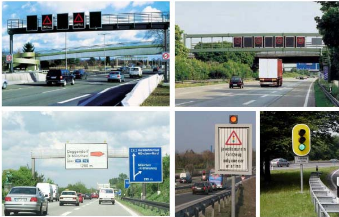
Abbildung 2: Kollektive Verkehrsinformations- und -leitsysteme in Deutschland Streckenbeeinflussungsanlagen (oben), Netzbeeinflussungsanlage (unten links); Zufussregelung in München (unten Mitte) und Bochum (unten rechts).
